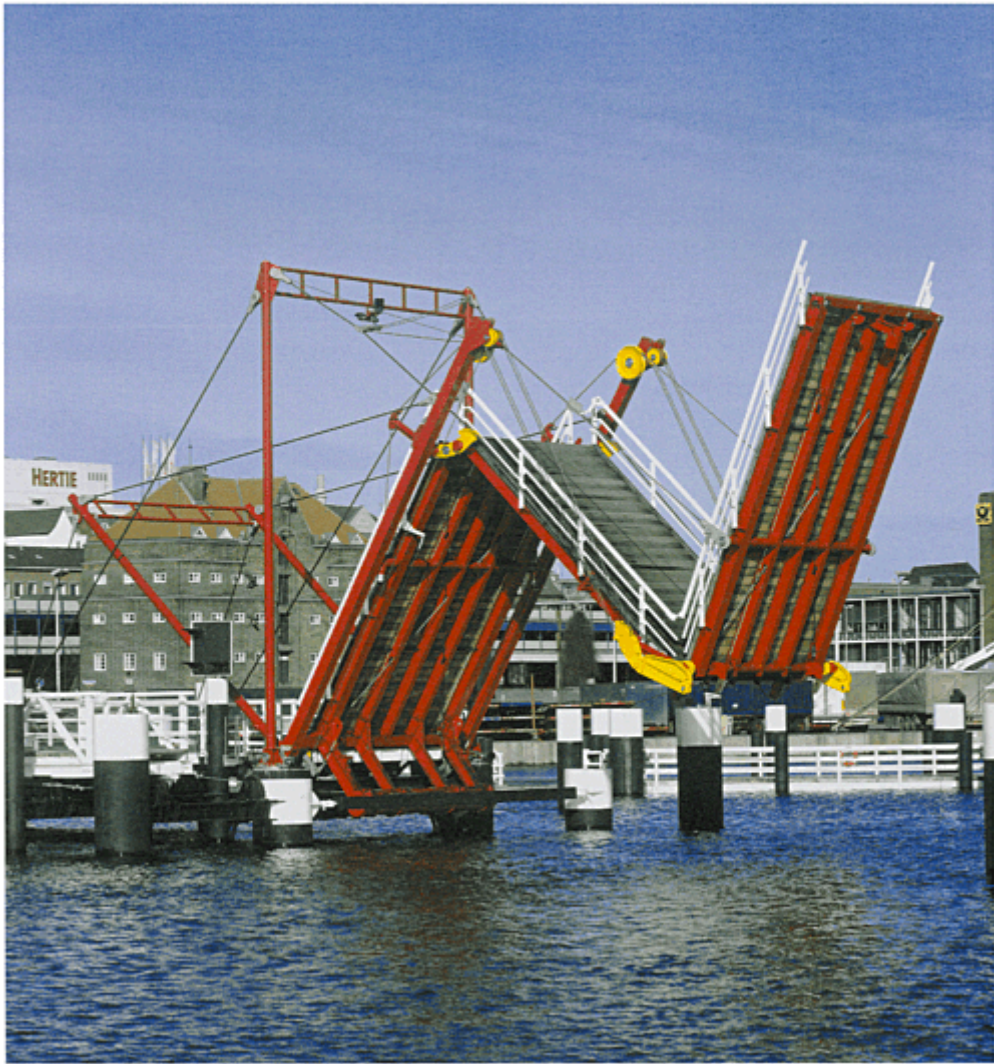
12.7 Kiel Hörn Bridge, 1997: the bridge folding
